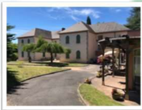
Résidence Jouhet Duranthon 21 route du kaolin EHPAD en cours de restructuration (fin des travaux avril 2026)
